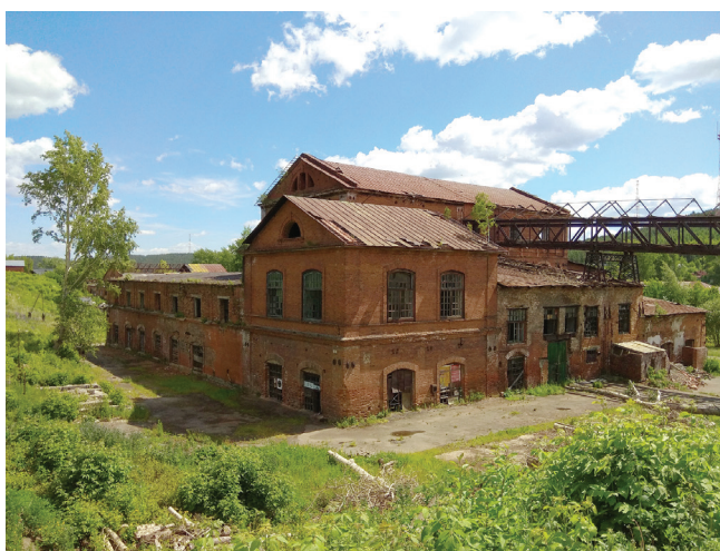
Рис. 2. Главное здание (доменный цех) Сысертского завода. Фото Ю.В. Ерохина, 2019 г.
