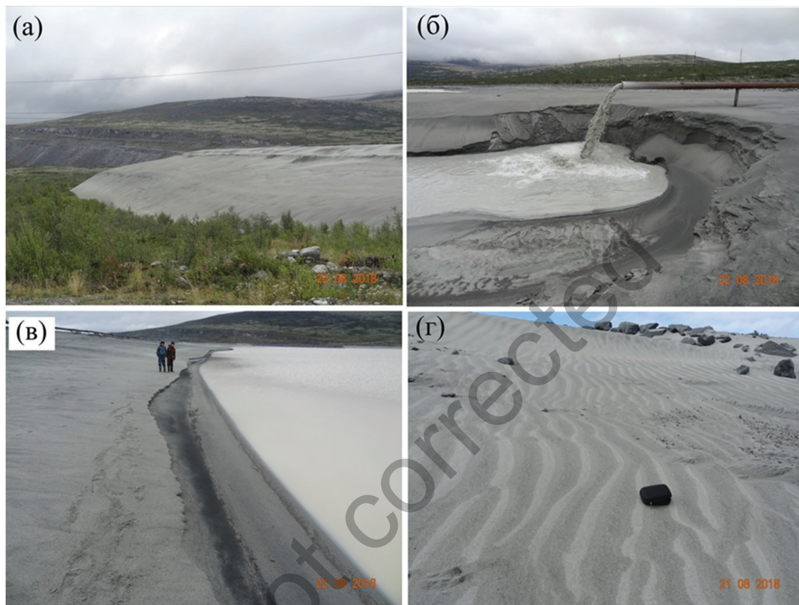
Рис. 5. Техногенно-фациальные зоны хвостохранилища Карнасурт-2: а – дамба; б – зона сброса («дельта»); в – пляж; г – зона эоловой переработки («дюна»).
